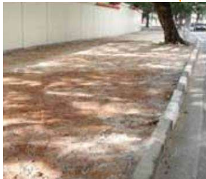
Figura 13 – Nivelamento e compactação do terreno
