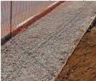
Figura 14 – Espalhamento da camada de Brita
