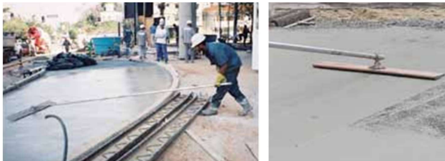
Figura 16 – Desempeno do concreto.
