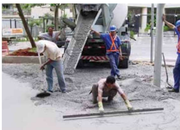
Figura 15 – Recebimento e espalhamento do concreto.
